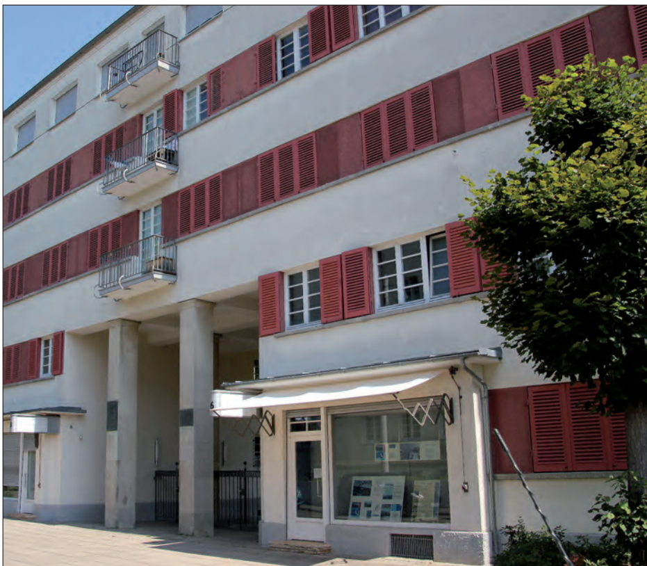
Auch fast 100 Jahre nach der Fertigstellung bewährt sich das Wohnkonzept des Architekten. Markant sind die Säulen und die schützenden Gittertore.
